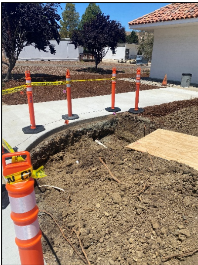
Trenching for Conduits
