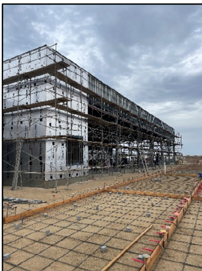
Stucco Scaffolding Exterior
