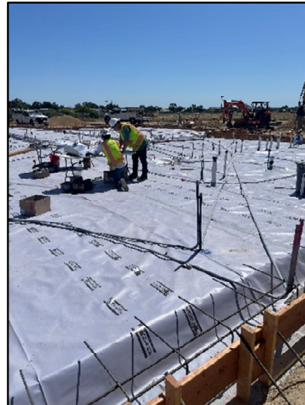
Under Slab Conduits
