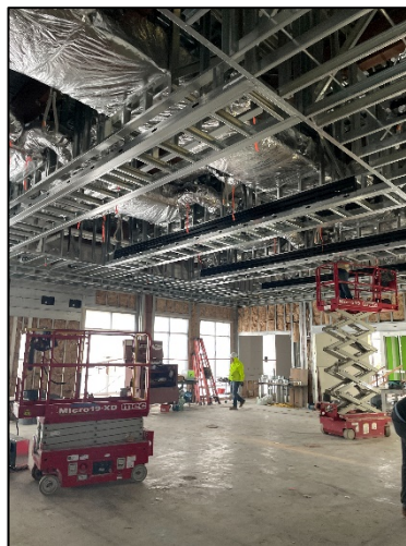
Interior Metal Stud Framing
