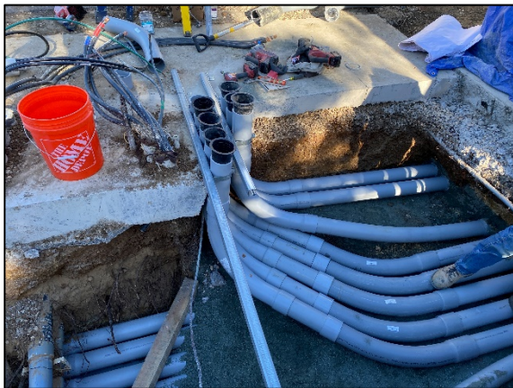
Conduit Stub Ups
