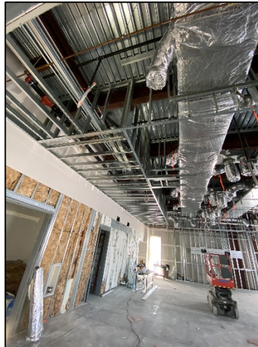
Metal Stud Framing
