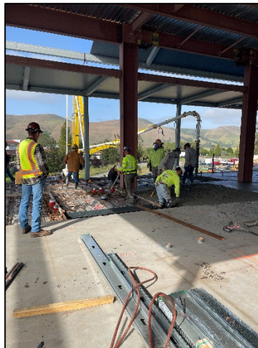
[ Final 2 nd Floor Concrete Pour ]
