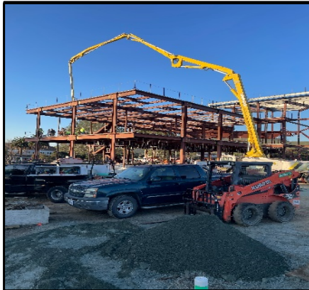
2 nd Floor Concrete Deck Pour
