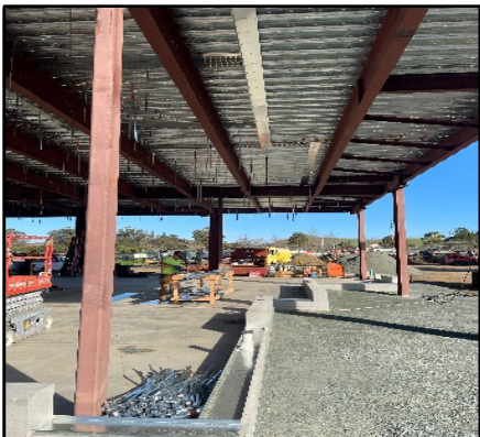
Exterior Metal Stud Framing
