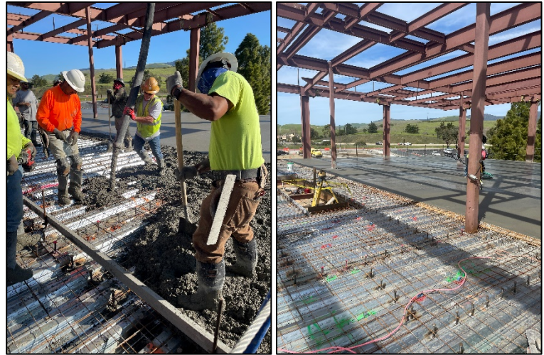
[ Concrete Deck Pour – 2 nd Floor ]
