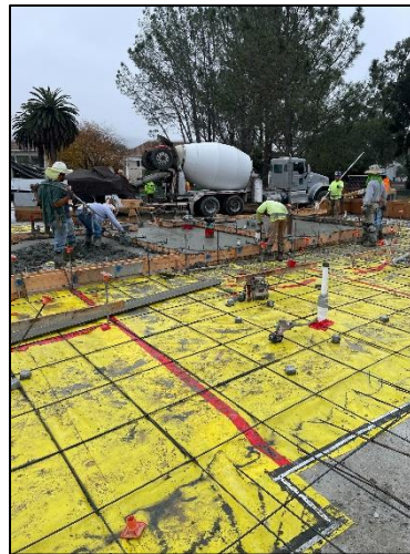
Slab on Grade Concrete Pour (West Side)
