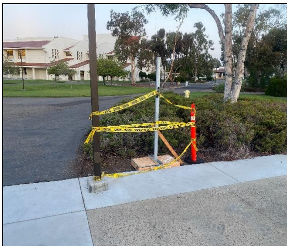
Sign Posts – Pending Concrete Pour
