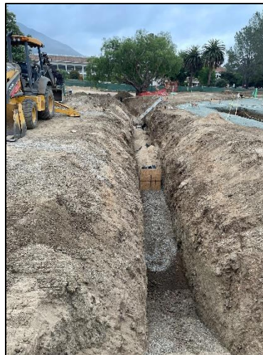
Site Storm Drain P.O.C.
