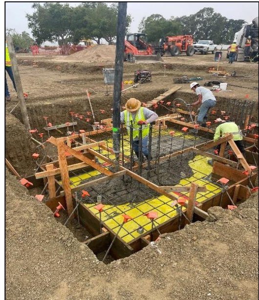
Pouring Elevator Pit
