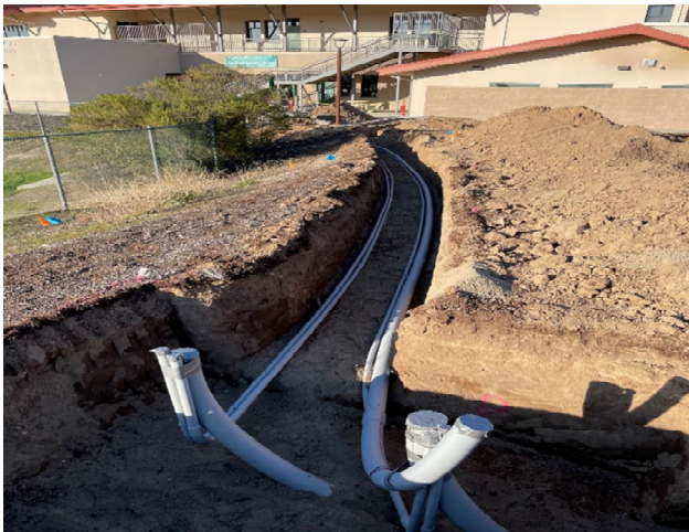
Underground Conduit Runs to N3200
