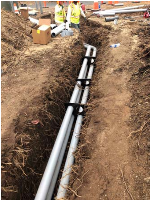
New Underground Conduits
