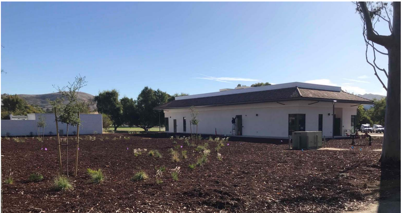
Data Center Exterior
