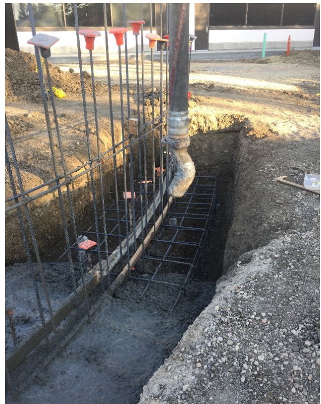
Concrete Plaza Foundation Pour
