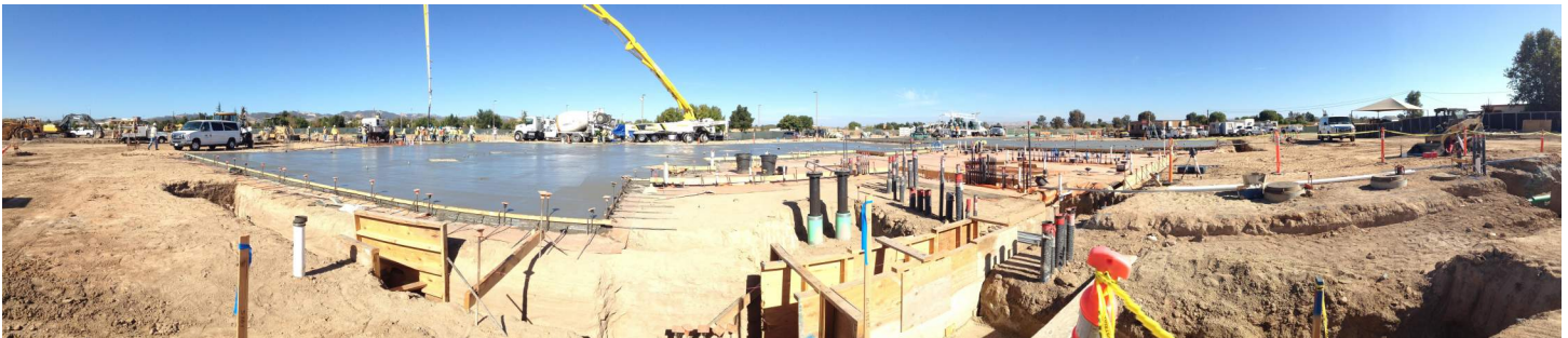
Building Slab On Grade Concrete Pour
