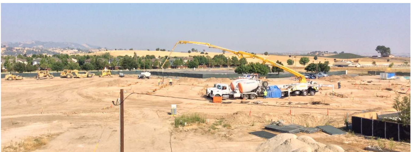
Pad Footing Concrete Pour
